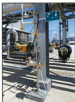
ภาพที่ 2.2-19 อุปกรณ์ชำระล้างฉุกเฉินในพื้นที่โครงการ
