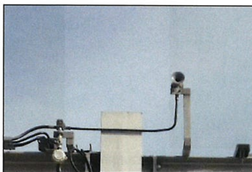
อุปกรณ์แจ้งสัญญาณฉุกเฉิน (siren)
