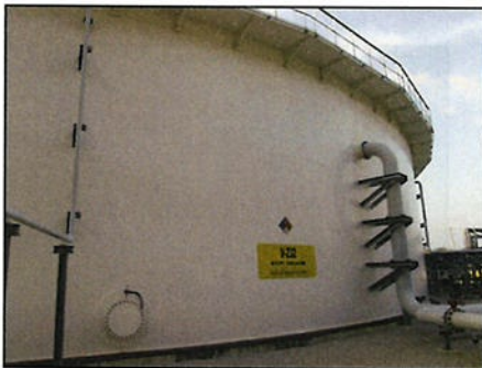
ภาพที่ 2.2-21 ระบบถังเก็บกักน้ำสำรองเพื่อการดับเพลิง
