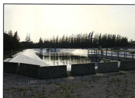
บ่อหน่วงน้ำ (Retention Pond)
