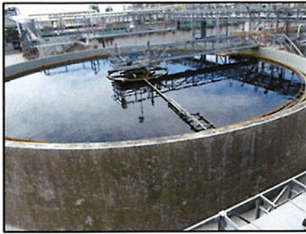
ภาพที่ 2.2-8 ระบบบำบัดน้ำเสียส่วนกลางของบริษัท ดาว เคมีคอล ประเทศไทย (เดิม HPPO)
